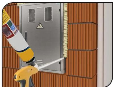
**Alcafoam Gun** è una schiuma poliuretaniche monocomponente per pistola da montaggio. Essicca con l'umidità dell'aria.
