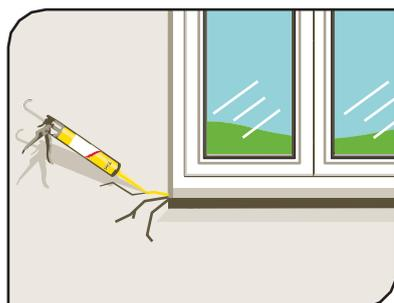
**Alcacril** è un sigillante monocomponente plasto-elastico a base di dispersione acrilica per la sigillatura di diversi tipi di materiali edili porosi. Supporta dilatazioni fino al 15%.
